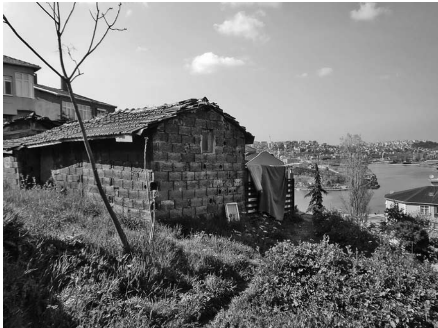
„Gecekondu“ heißt soviel wie „Über-Nacht-gebaut“. Die Ärmsten der Armen bauen immer wieder „illegal“ solche Behausungen, weil der türkische Staat sich um die Ärmsten nicht kümmert. Armut ist ein zentrales Problem der Türkei. Auf dem Fotos ist ein „Gecekondu“ mitten in Istanbul zu sehen.
